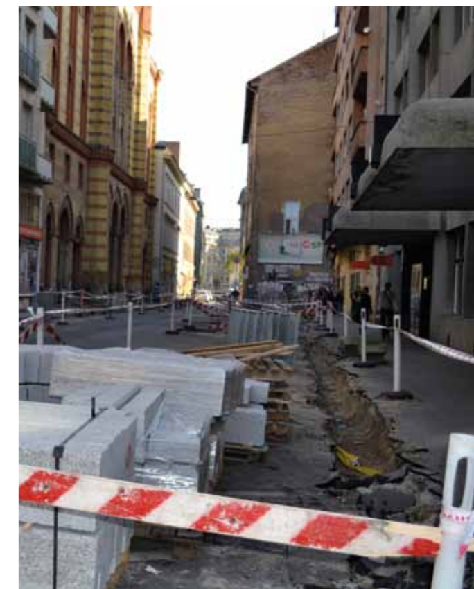
A Rumbach S. utca a Madách téri rekonstrukció részeként valósul meg
